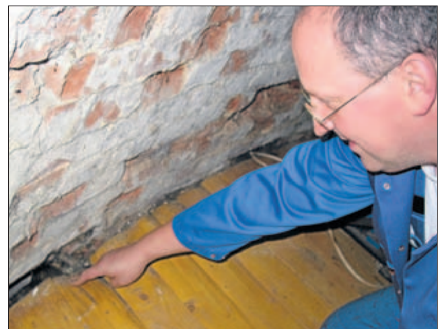
Mühlenwart Thorsten Geschke zeigt auf verschimmelte Holzdielen, die nicht mehr belastbar sind. Foto: Fochler
