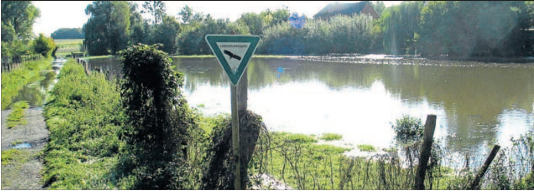
Derzeit führt die Schunter bei Flechtorf Hochwasser. Im nächsten Jahr soll das Flussbett auf großen Teilen im Bereich Flechtorf renaturiert werden. Die Maßnahme ist inzwischen genehmigt. Foto: Werner Kison
