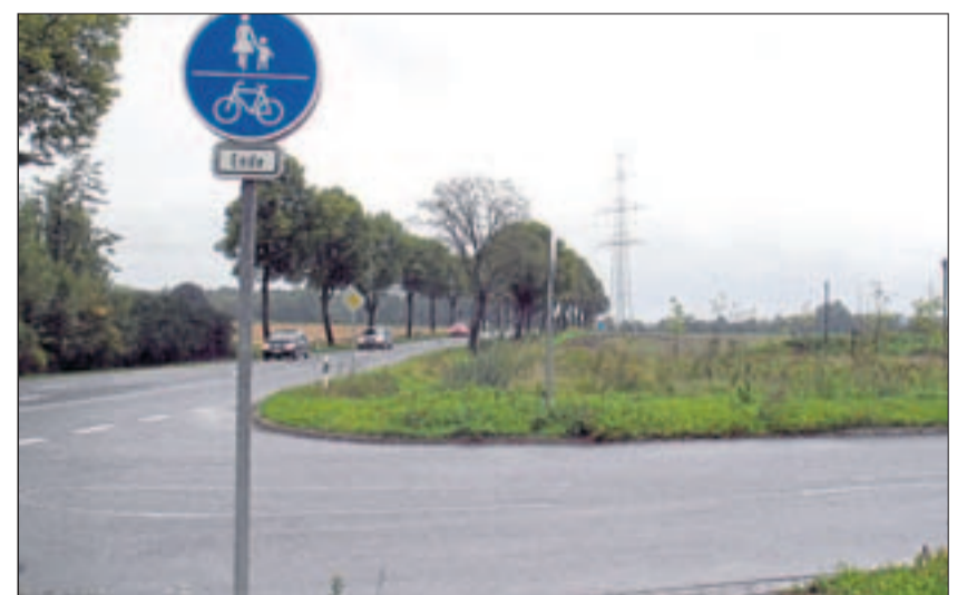
Wenn alles gut läuft, kann der geplante Weiterbau des kombinierten Rad- und Fußweges im nächsten Jahr bis zur B 248 erfolgen. Foto: Werner Kison
