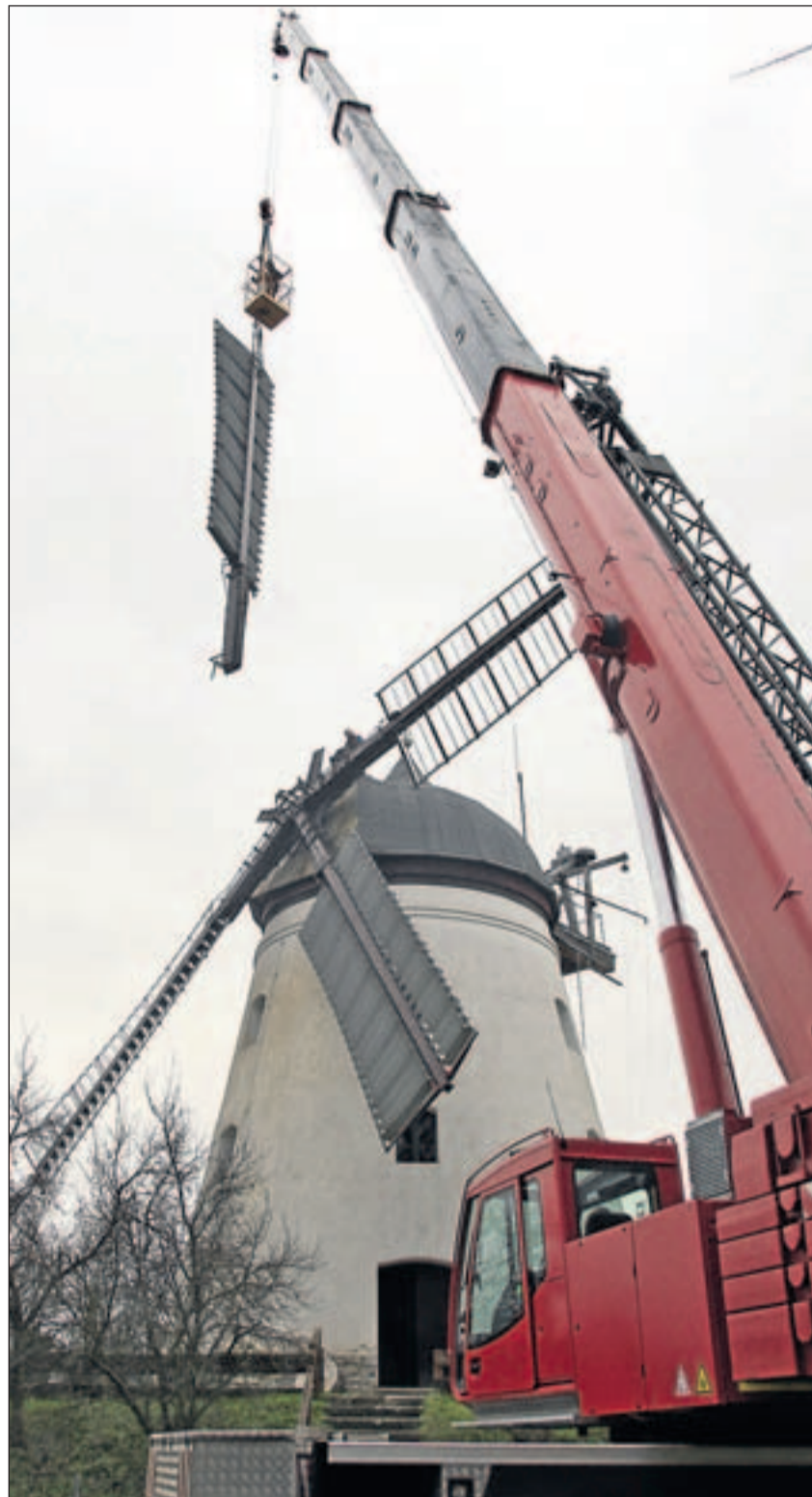
Der zweite der fünf Flügel hängt am Haken des Krans. Im Korb über dem Flügel steht Michael Rieckmann. Fotos: regios24/Sebastian Priebe
