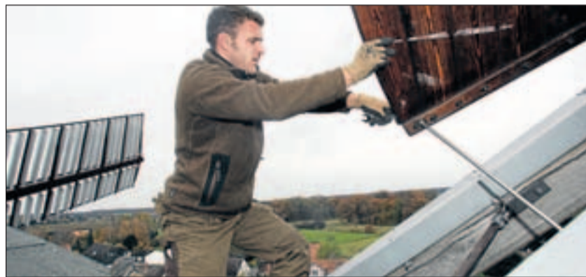
André Pamcianeschi befestigt in luftiger Höhe das kleine Windrad zum Drehen des Mühlenkopfes wieder. Wegen des starken Windes mussten die Arbeiten auf Montag verschoben werden. Fotos (2): regios24/Sebastian Priebe
