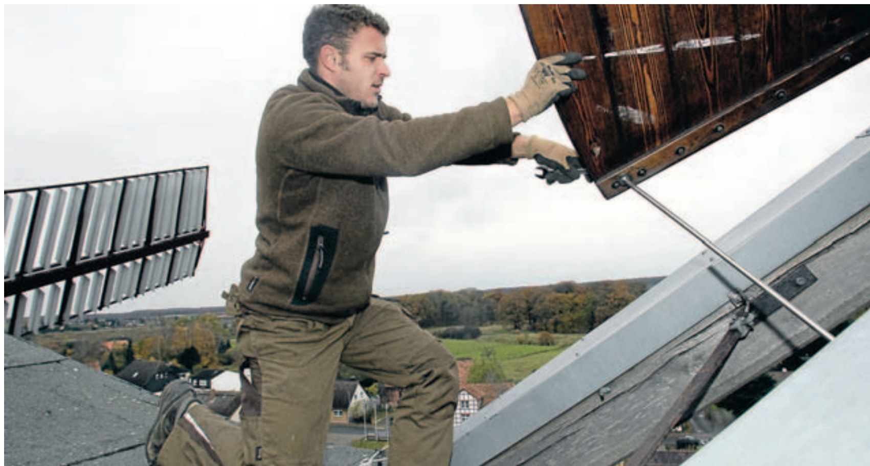
André Pamcianeschi arbeitete im November 2010 in luftiger Höhe. Damals wurden die Flügel der Holländer-Windmühle Wendhausen aus Sicherheitsgründen abmontiert. Archivfoto: regios24/Sebastian Priebe
