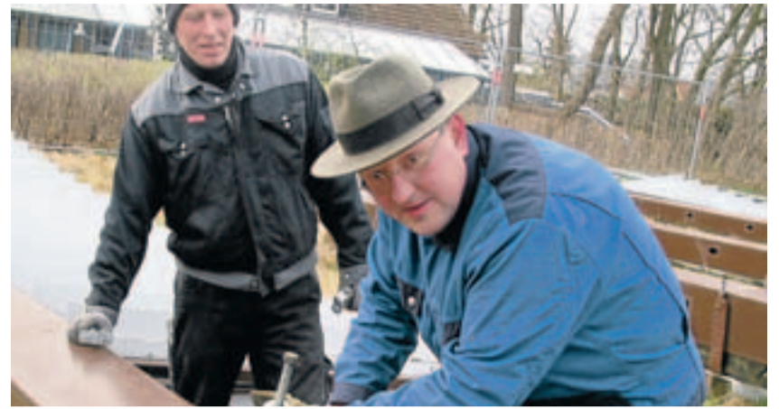
Andreas Schmiel (links) von der Firma Pätzmann und Thorsten Geschke demontieren die Aluminium-Lamellen von den Stahlruten. Foto: Fochler
